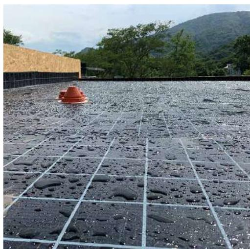
\*Le test est destiné à démontrer la qualité de BYTUM BASE 2500 même en cas de pluie battante. Cependant, pour l'imperméabilisation des toitures planes, elle doit être utilisée en combinaison avec BYTUM SLATE 3500.
